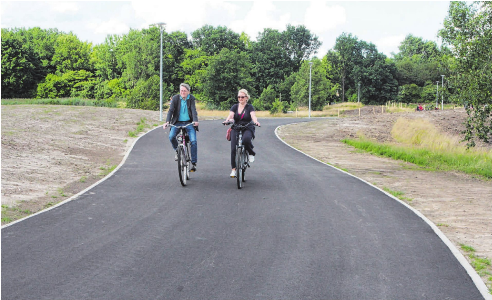
Der ausgebaute Weg über die frühere Rennbahn war der erste Schritt zur Öffnung des Geländes.
