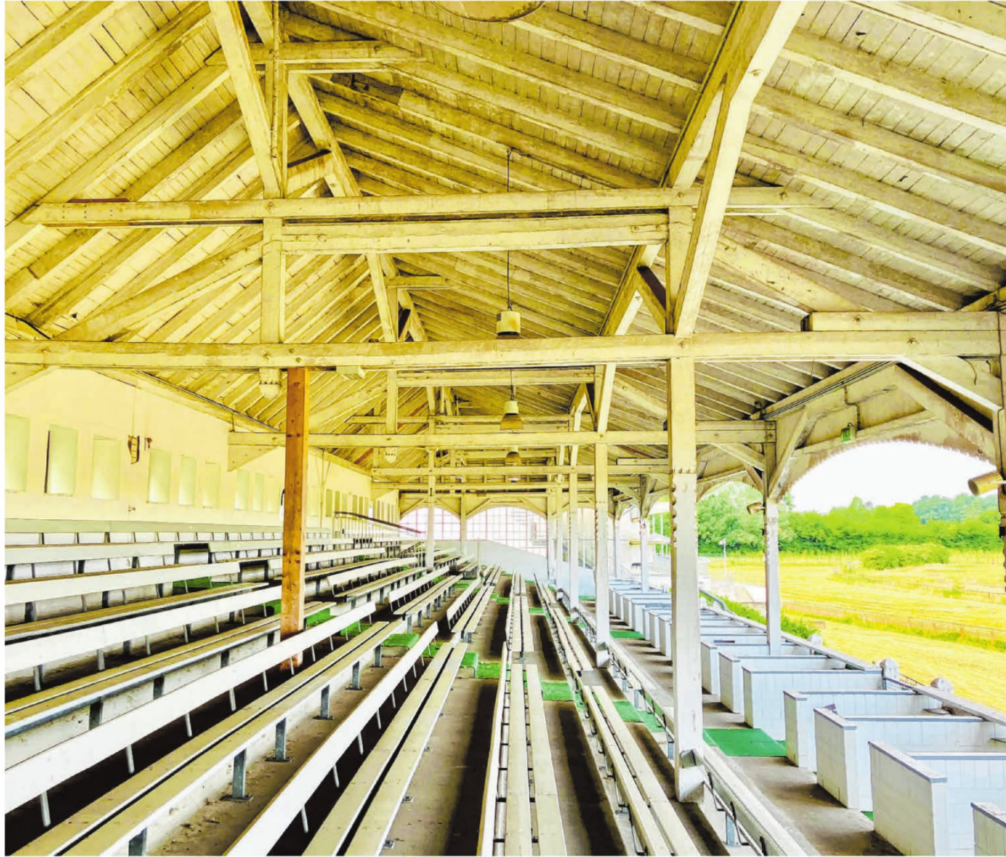
Die Tribüne an der Galopprennbahn soll kulturell genutzt werden, muss aber mittelfristig saniert werden.
