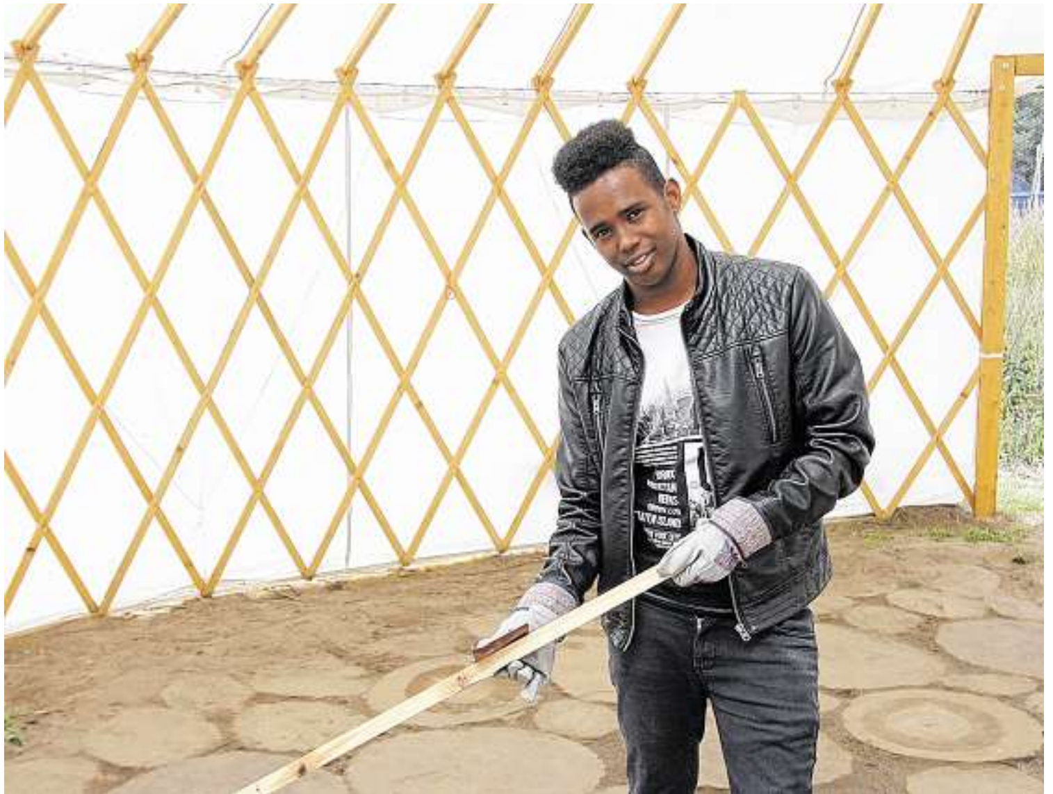
Abd Ali Shansadiin baut an der großen Jurte mit, die im Kulturgarten neben dem Übergangwohnheim an der Arberger Heerstraße entsteht. Viele freiwillige Helferinnen und Helfer packen mit an, Unternehmen spenden Material und Lebensmittel. FOTOS: PETRA STUBBE
