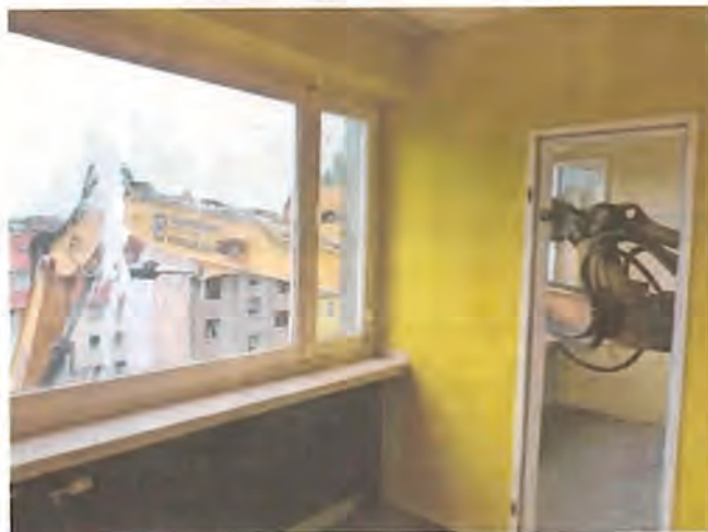
Der Bagger ist schon da: Im dritten Stock ragt der Baggerarm in ein Zimmer hinein. Das Werk „Vorzeichen“, hierbei kooperiert der Künstler Carsten Schade mit der Abrissfirma Wimmelbrücker, verweist auf das, was kommen wird.
