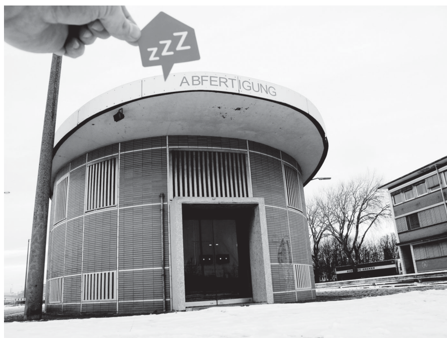
Lkw-Zollabfertigung in den Bremer Überseehäfen: Diese Nutzung ist Schnee von gestern, heute beherbergt das Gebäude die ZwischenZeitZentrale
