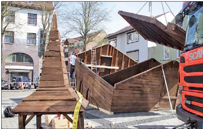
Umbauarbeiten auf dem Marktplatz.
