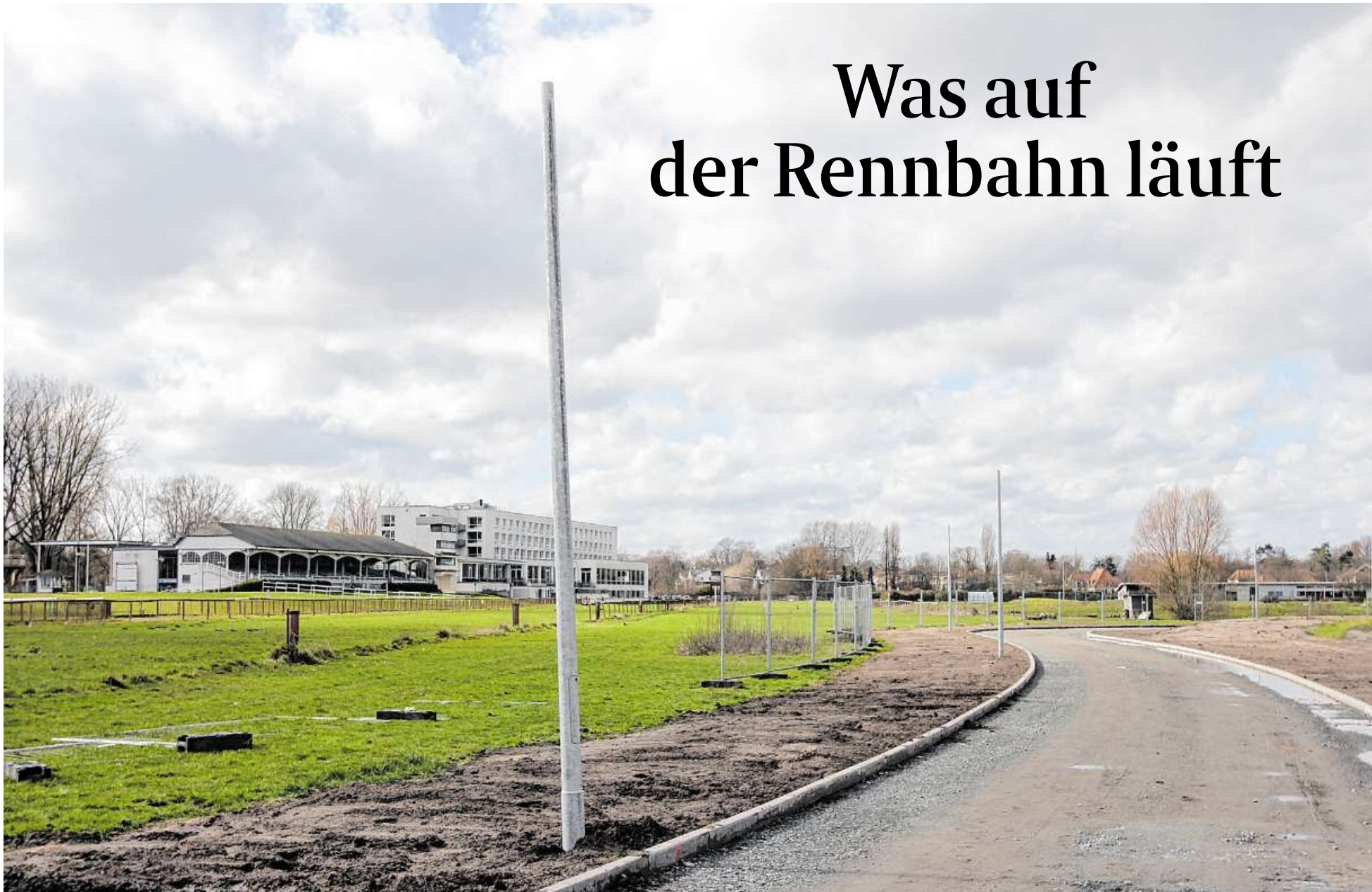
Lichtmasten markieren den Weg über die Rennbahn in Sebaldsbrück, der in den kommenden Wochen offiziell freigegeben werden soll.
