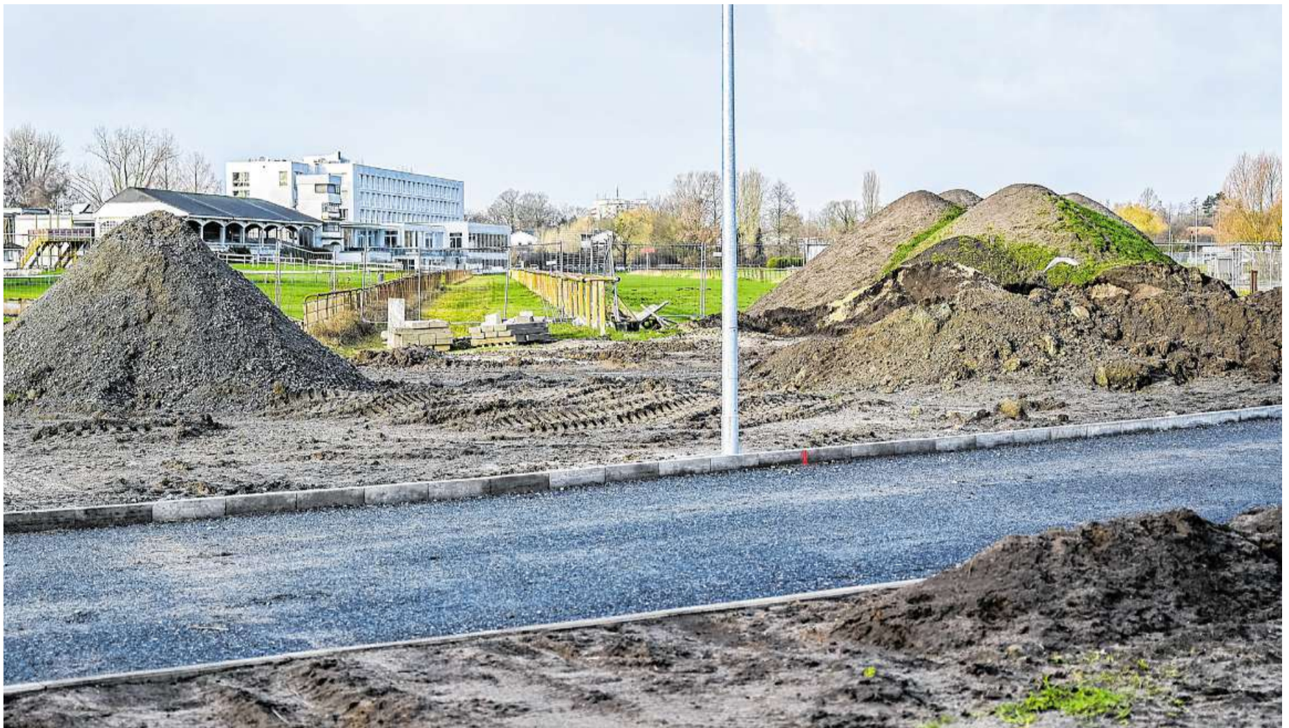
Das Bauvorhaben geht voran: Die Nord-Süd-Verbindung von der Vahr nach Hemelingen führt auch über die lange Zielgerade des Rennbahnovals. Die Lichtmasten für die Beleuchtung werden gerade aufgestellt, die Asphaltdecke fehlt noch.
