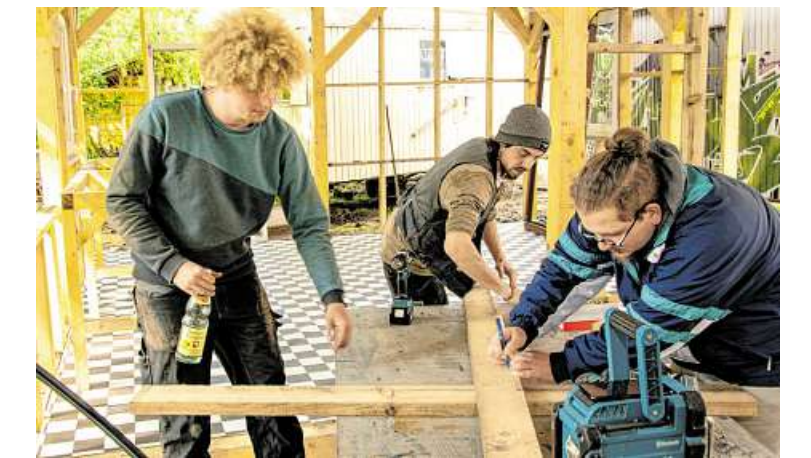
Ehrenamtliche bauen die Küche im neuen Plenumsgebäude.
