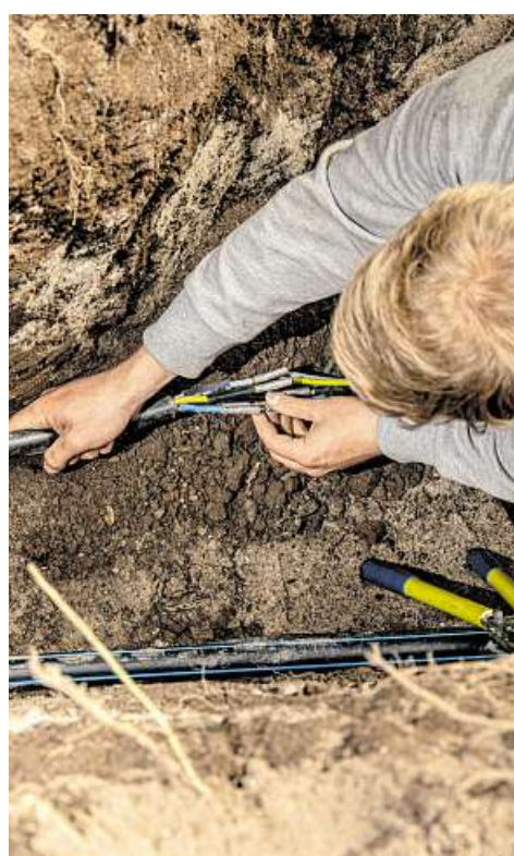
Unterirdisch sollen Kabel verlaufen.
