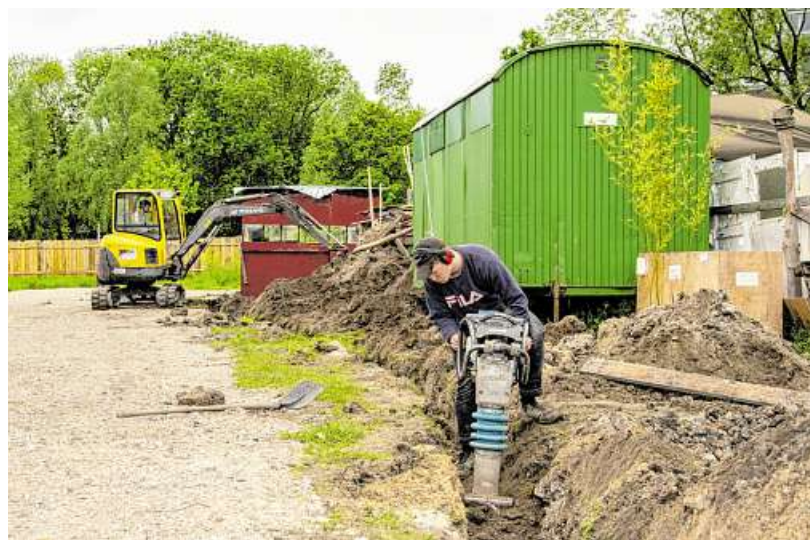
Finn Herzog arbeitet mit Hochdruck daran, den Graben zu schließen.
