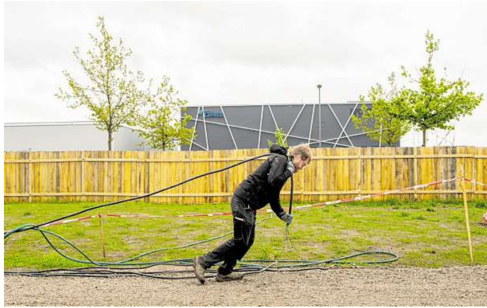
Michael Speer zieht ein Kabel über einen neu gemachten Weg.
