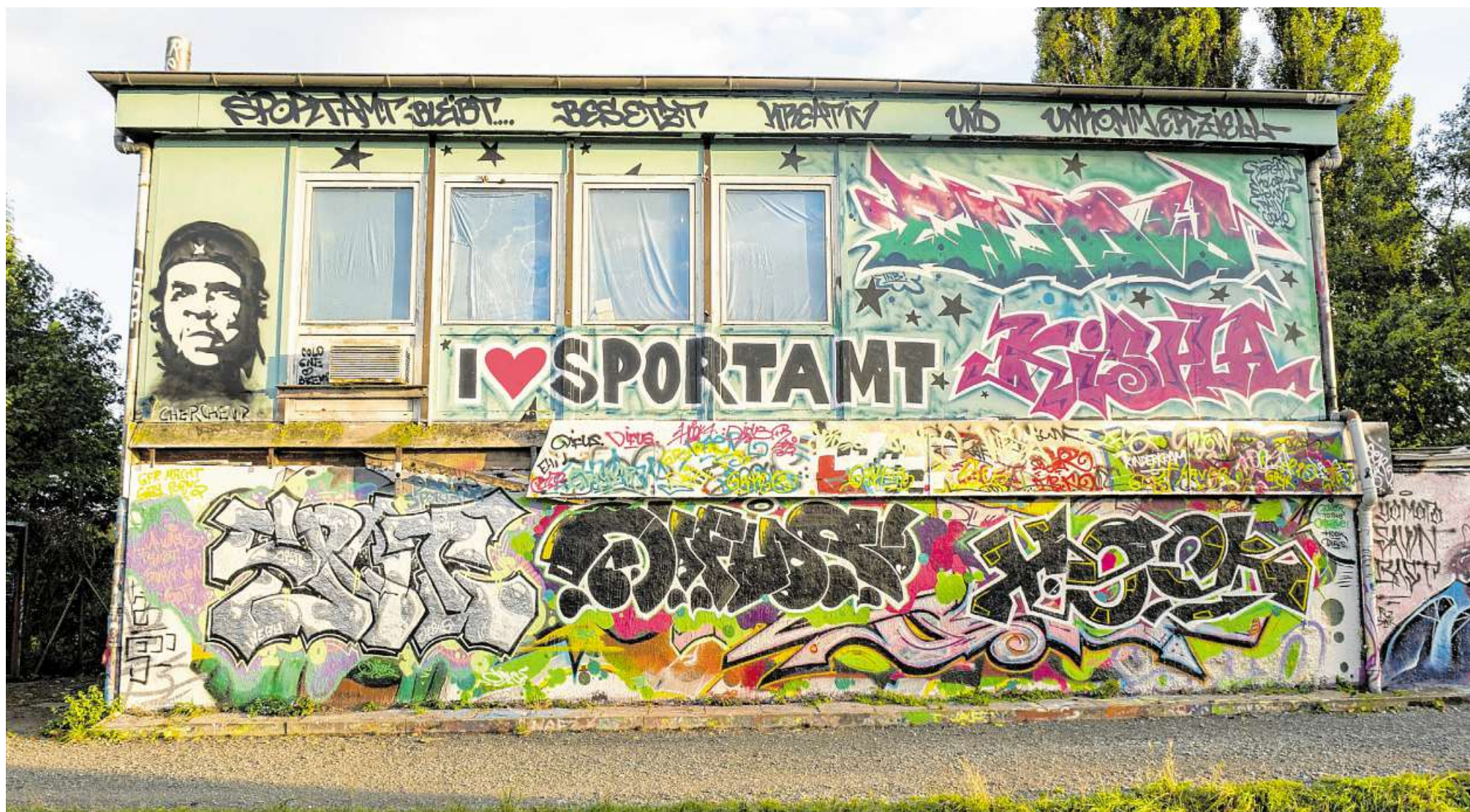
Das Alte Sportamt in der Pauliner Marsch wurde in den Siebzigerjahren als Bürogebäude gebaut. Bis 2006 arbeiteten dort Beamte.
