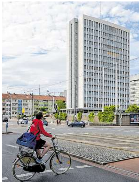
Das ehemalige Bundeswehrhochhaus an der Falkenstraße.
