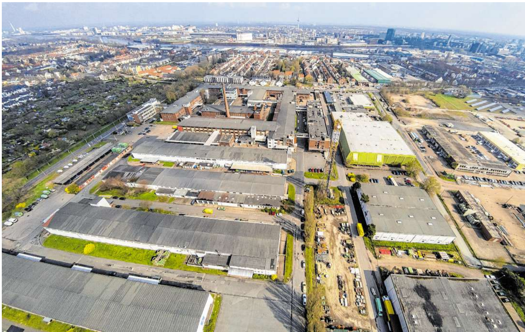
Justus Grosse will das Brinkmann-Areal (auf dem Bild links) in Woltmershausen entwickeln. Pläne gibt es auch zusammen mit der SWB für das Gelände am Gaswerk (rechts). FOTO: FR
