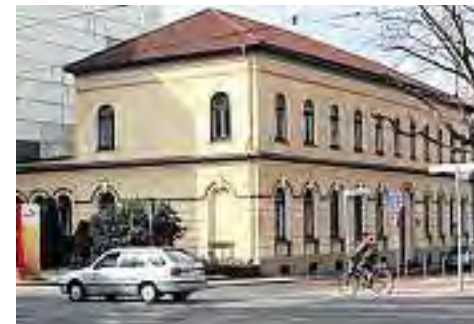
Steht leer – das alte Verwaltungsgebäude der Haake-Beck-Brauerei. FOTO: GERBRACHT
